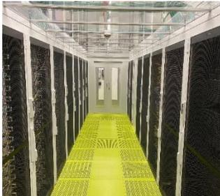
Der empfohlene Temperaturbereich (Zulufttemperatur) in der Klimatisierung in einem Rechenzentrum sollte entsprechend der DIN-50600 zwischen 20 und 27 °C liegen. Je nach Standort gibt es optimale Kühlkonzepte:
